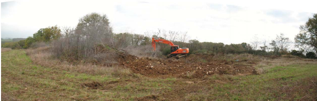
Panoramique début travaux, depuis le Sud du dépôt
