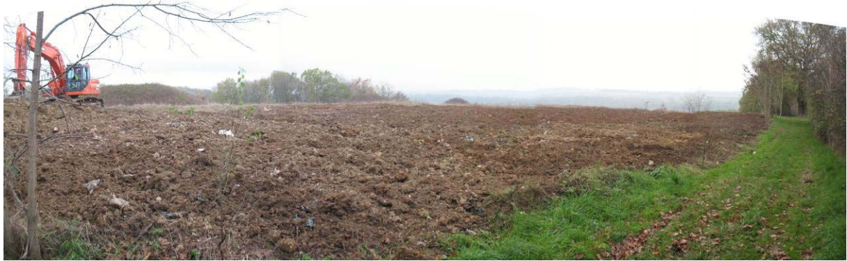
Vue générale en fin de mission, depuis l'angle Sud-Est
