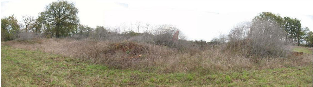
Panoramique début travaux, depuis le Nord du dépôt
