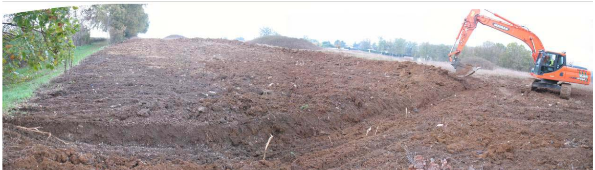
Vue générale en fin de mission, depuis le Nord
